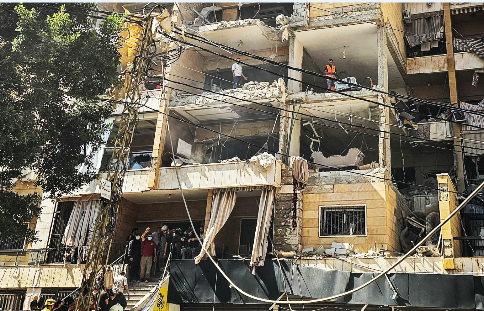
الاضرار بالمبنى المستهدف في الضاحية الجنوبية
