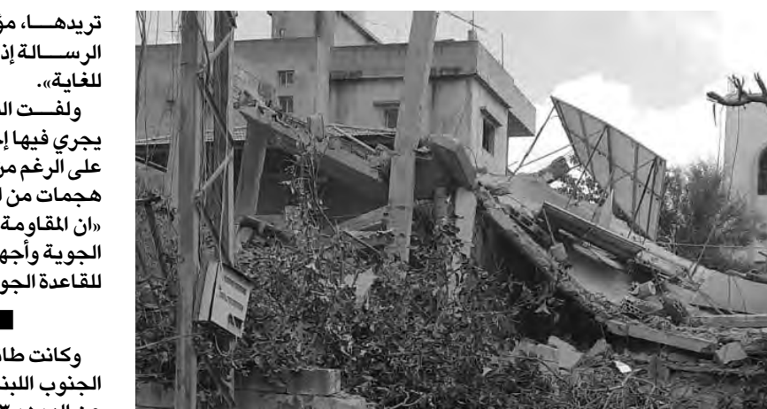
استهداف المنازل في قرى الجنوب اللبناني
