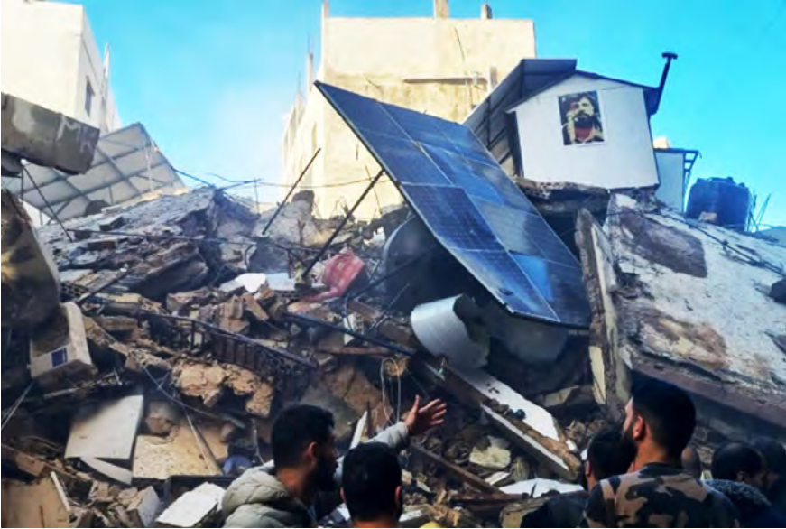
المبنى المنهار في الشويقات
