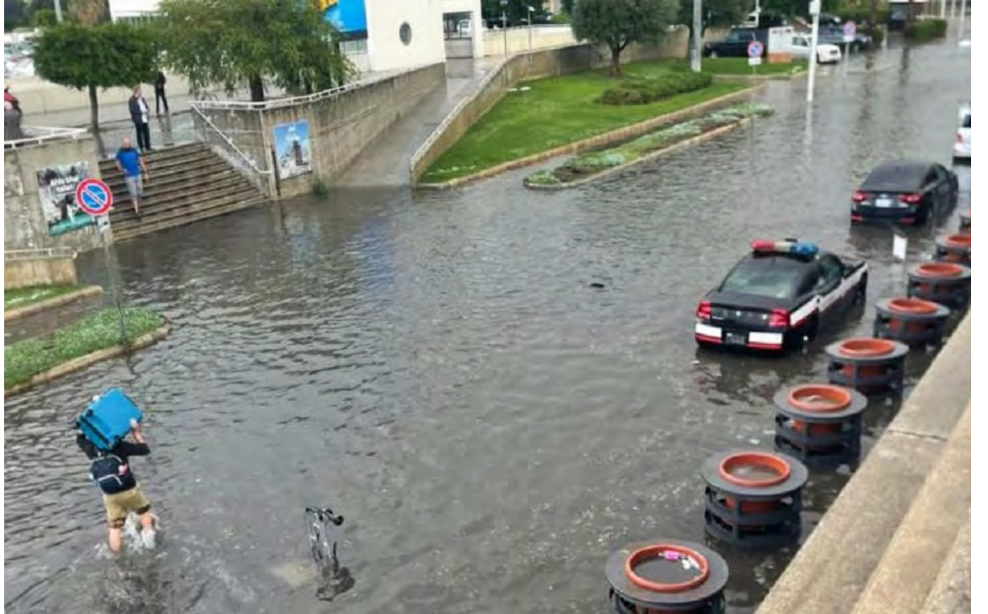
مياه الامطار أغرقت مطار بيروت من الداخل والخارج
