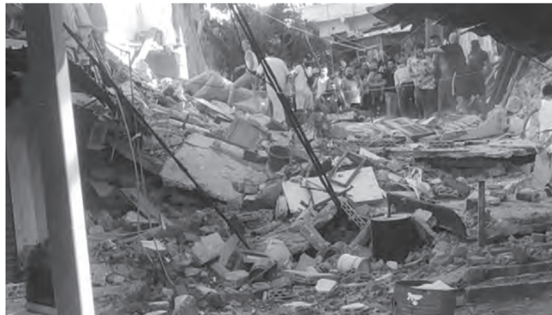
انهيار مبنى في طرابلس
